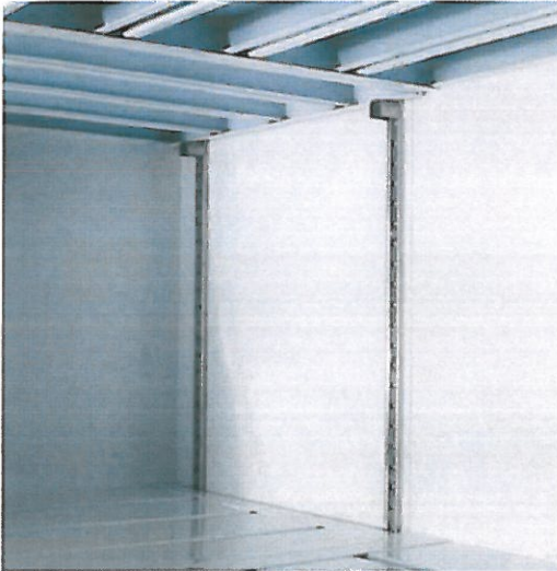
Bild 15. Montage der Regalträger und der Regale
